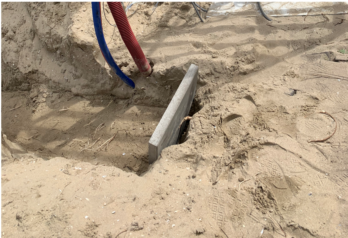
Foto 1: funderingsleuf en betontegel.
